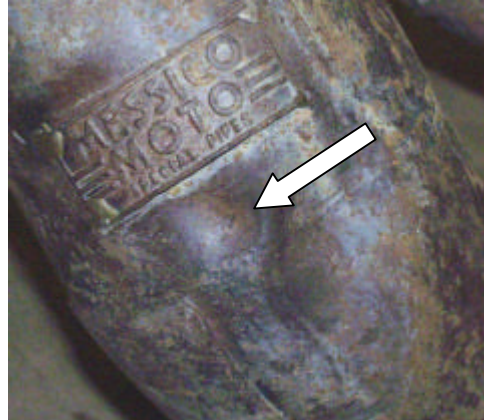
Ungünstig: Beule im Bereich der Schweißnähte!
